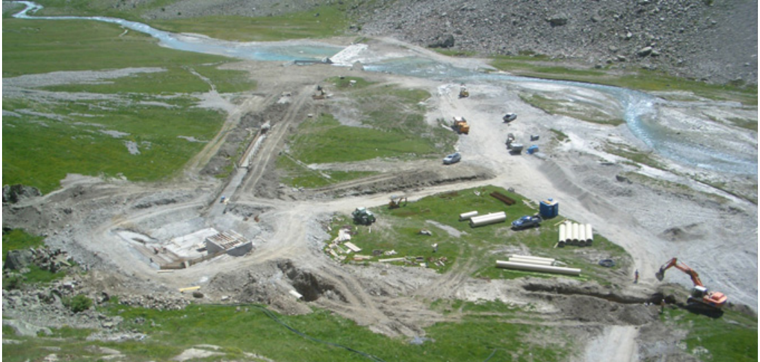
Construction du déssableur de 800 m 3 à 1965 m d'altitude
